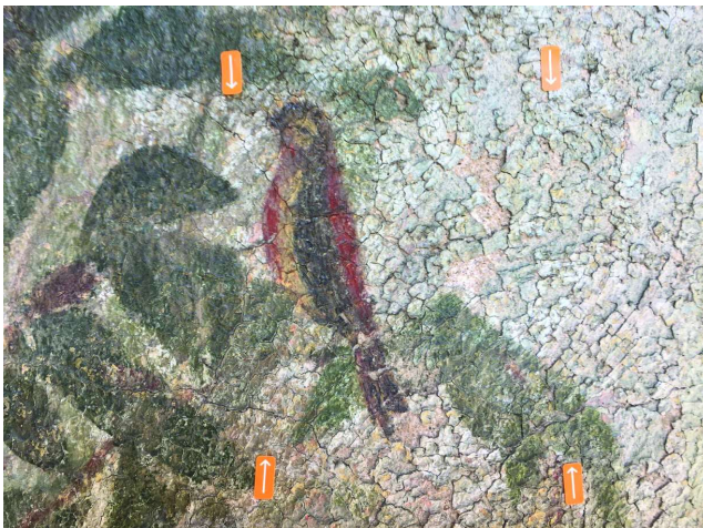
Radebeul . private Villa Detail, während der Festigung 2018
